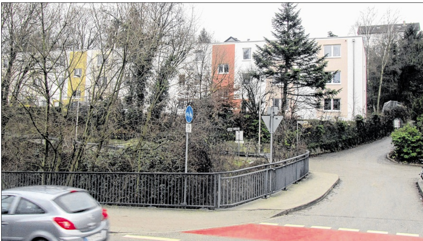
NEU GEBAUT worden ist dieses Heim für Flüchtlinge. Es soll im Frühjahr 2015 bezogen werden. Das schmucklose Gebäude steht „An der Schießmauer“ bei Rinklingen. Die Stadt investiert rund 2,8 Millionen und vermietet das Haus an den Landkreis.
